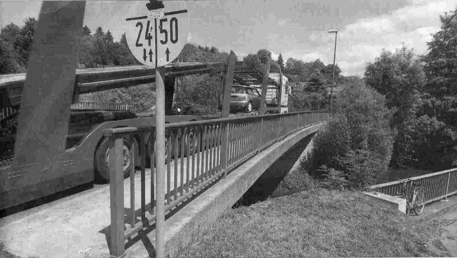
In Komelimumster führt die Bundesstraße 258 über die Inde. Die Tragfähigkeit dieser Brücke muss erhöht werden. Deshalb stehen, wahrscheinlich ab Sommer 2007, größere Baumaßnahmen an. Foto: Archiv
